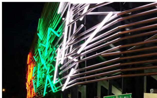
Die durch den Hauptsponsor WWK Versicherung finanzierte Außenfassade des Bundesliga-Stadions wurde durch die Architekten Bernhard & Kögl konzipiert. Highlight sind die 170 LED Leuchtstäbe der Firma Zumtobel, die von livebau in die Rohrkonstruktion integriert wurden. Im April 2018 wurde die WWK-Arena mit dem Förderpreis der Langner'schen Stiftung für Architektur und Denkmalschutz ausgezeichnet.
